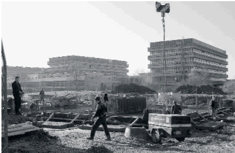
Ein eigenes Gebäude für XLAB: Nach dem „ersten Spatenstich“ Anfang September zeigt das Bild die Arbeiten am Fundament Mitte November. Für die Fertigstellung des Neubaus im Uni-Nordbereich sind 15 Monate eingeplant (Foto: Wolfgang Tambour)
