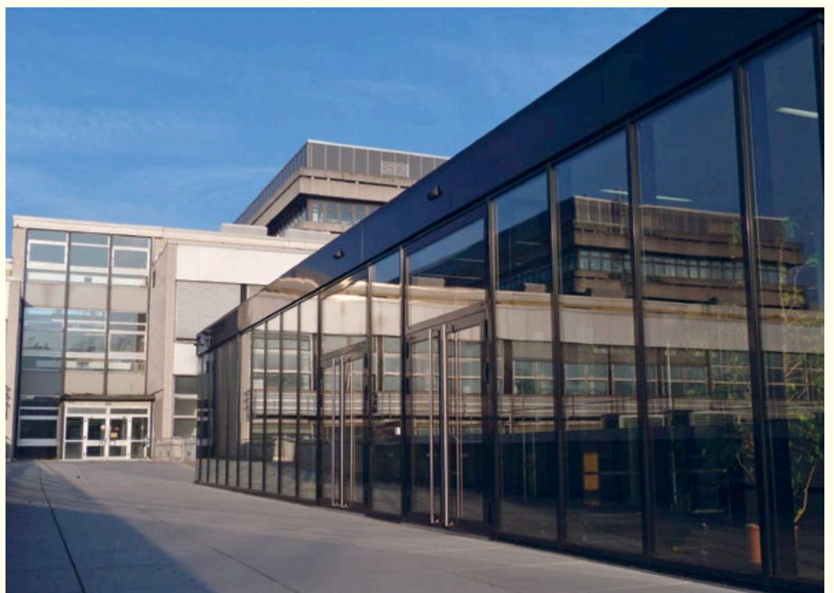
Neu spiegelt Alt: Neue Eingangshalle mit Zugängen zum Chemikalienlager und zu den Hörsälen im alten Gebäude.
